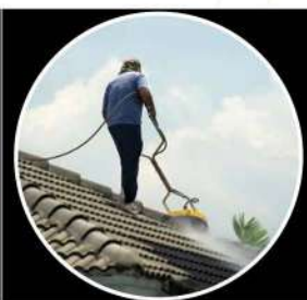
Limpieza a presión del tejado o las tejas
